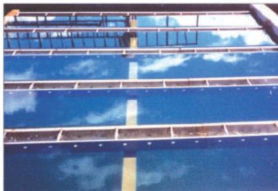
트리프는 상수도여과지에 설치하여 침전지의 상등수가 여과지로 이송되면 트리프를 통해 여과지에 공급되며, 여과층이 막혀 모드불현상이 생겨 자동역세척이 이루어질 때 역세척 퇴수 및 유출수가 트리프를 통하여 유출되어집니다.
