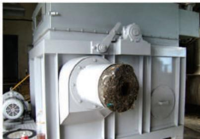
협잡물 및 침사제거기는 스크린과 무축 스크류 콘베이어가 조합된 일체형 기기로서 유입 수중에 포함된 협잡물과 침사를 동시에 제거 합니다. 협소한 장소에 설치가 가능하며 유지 관리가 용이합니다.
