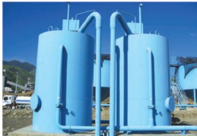
전자동 급속여과기는 SIPHON 원리를 이용한 완전 전자동 여과장치로서 수원지의 설비 규모를 축소하고 양질의 수원을 생산할 수 있도록 설계하였습니다.
