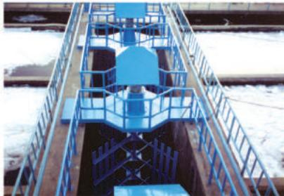
좋은 Floc을 만들기 위해서는 우선 약품 침전지에 유입되는 원수와 유산반토, 소석회등의 악물을 빠른 속도로 잘 혼합하는 것이 중요합니다. 당시 혼화기는 수리학적으로 원활하게 설계된 수직 임페라에 의하여 유입원수를 완전히 교반하여 난류가 되도록 해서 악물과 혼합이 잘 되도록 설계되어 있어 그 성능이 우수한 제품입니다.
