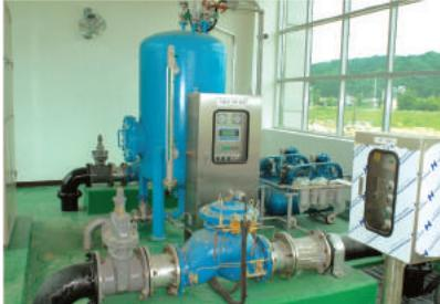
관로에서 밸브를 급속하게 열거나 닫을 때, 또는 펌프의 기동, 정지 시 유체의 흐름에 급격한 변화가 발생하면 압력이 파동하여 유속도 급격한 변화를 수충격현상이라 한다. 수충격현상은 정전과 같이 예고 없이 발생되며 입력의 급격한 상승, 하강(부압) 등을 일으키므로, 배관 시스템의 안전을 위해서는 수충격 완화설비를 설치하여 운전 중 예기치 않은 상황에서도 관로내의 입력을 이정한 범위내로 제어하도록 해야합니다.
