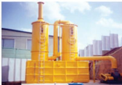
염소가스중화장치는 상하수도 및 하수증발처리의 살균소독에 사용되는 유독성염소가스 누출로 인한 재해를 방지하고 공공의 안전을 확보하는 장치로서 염소공병저장소 및 염소투입실에서 염소가스가 누출하면 염소가스 경지기의 경고와 동시에 자동으로 송풍기 중화액펌프가 작동하여, 누출가스는 흡입되어 탑하부에서 상부로 보내지고 중화액은 탑상부에서 하부로 분사되어 탑내의 충전물에서 기액 접촉에 의한 기체 흡수가 되어 기준치 이하로 중화되는 장치입니다.
