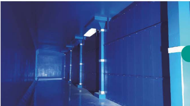
LH 화성 동탄 저,고 배수지 PDF도류벽 설치 무양카공법 설치
