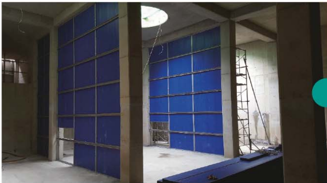
창원시 하수처리장 PDF간벽 시공
