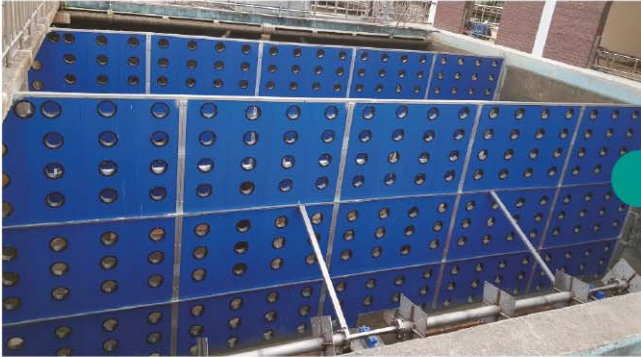
경남 김해시 삼계정수장 침전지 PDF정류벽 시공
