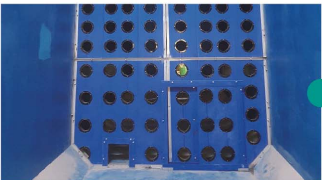
강원도 철원군 동송정수장 침전지 PDF정류벽 시공
