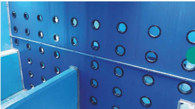
광주광역시 용연정수장 PDF정류벽 시공
