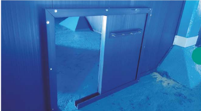
대전광역시 월평정수장 배수지 PDF도류벽 무양카공법 설치
