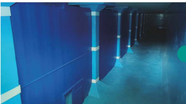
평택시 국제화배수지 PDF도류벽 무양카공법 설치
