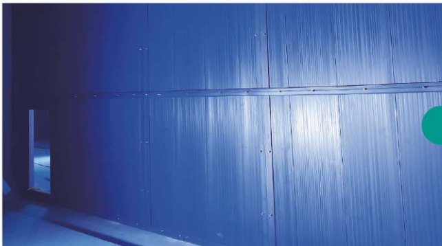
울산광역시 강동, 아음배수지 PDF도류벽 설치
