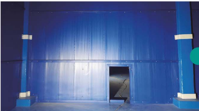
LH 인천검단배수지 PDF도류벽 무양카공법 설치
