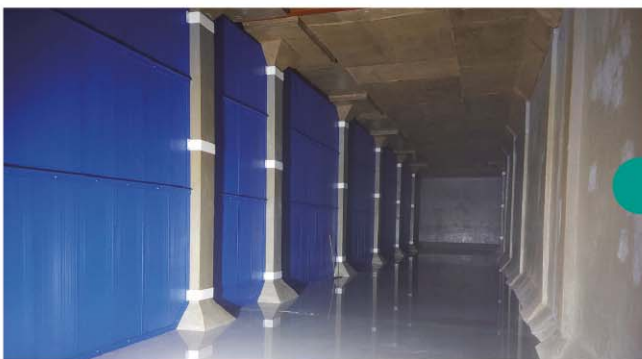
이천시 현대화사업 정수지 PDF도류벽 무양카공법 설치
