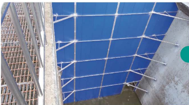
안양시 석수하수처리장 PDF간벽 시공
