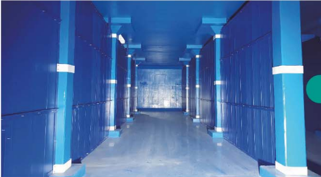
LH 김포 한강신도시 배수지 PDF도류벽 무양카공법 설치
