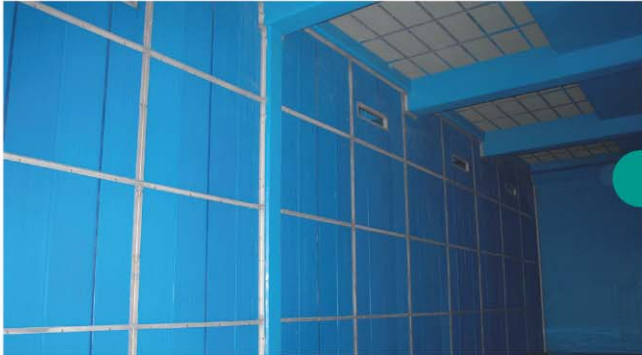
광주광역시 효천하수처리장 PDF간벽 시공
